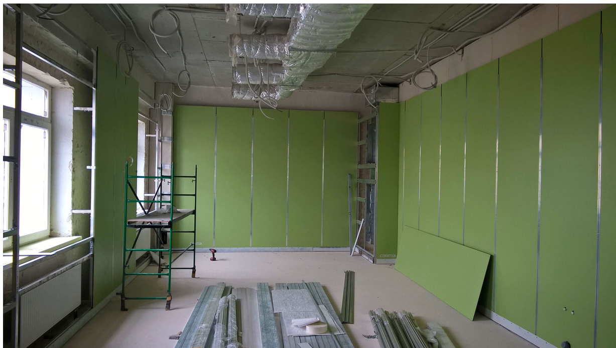
Продолжается монтаж системы ограждающих конструкций чистых помещений на объекте Областной перинатальный центр г. Самара.
