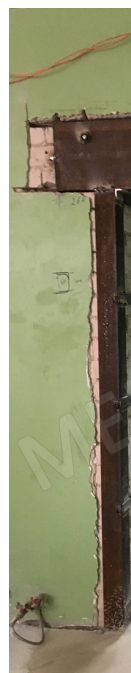
Завершен монтаж усиления дверного проема для установки рентгенозащитной двери.
